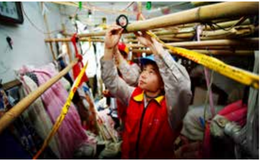
为用电困难户整理室内走线
