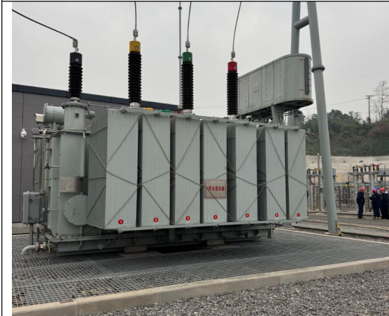
1#主变（集油坑铺设石子）
