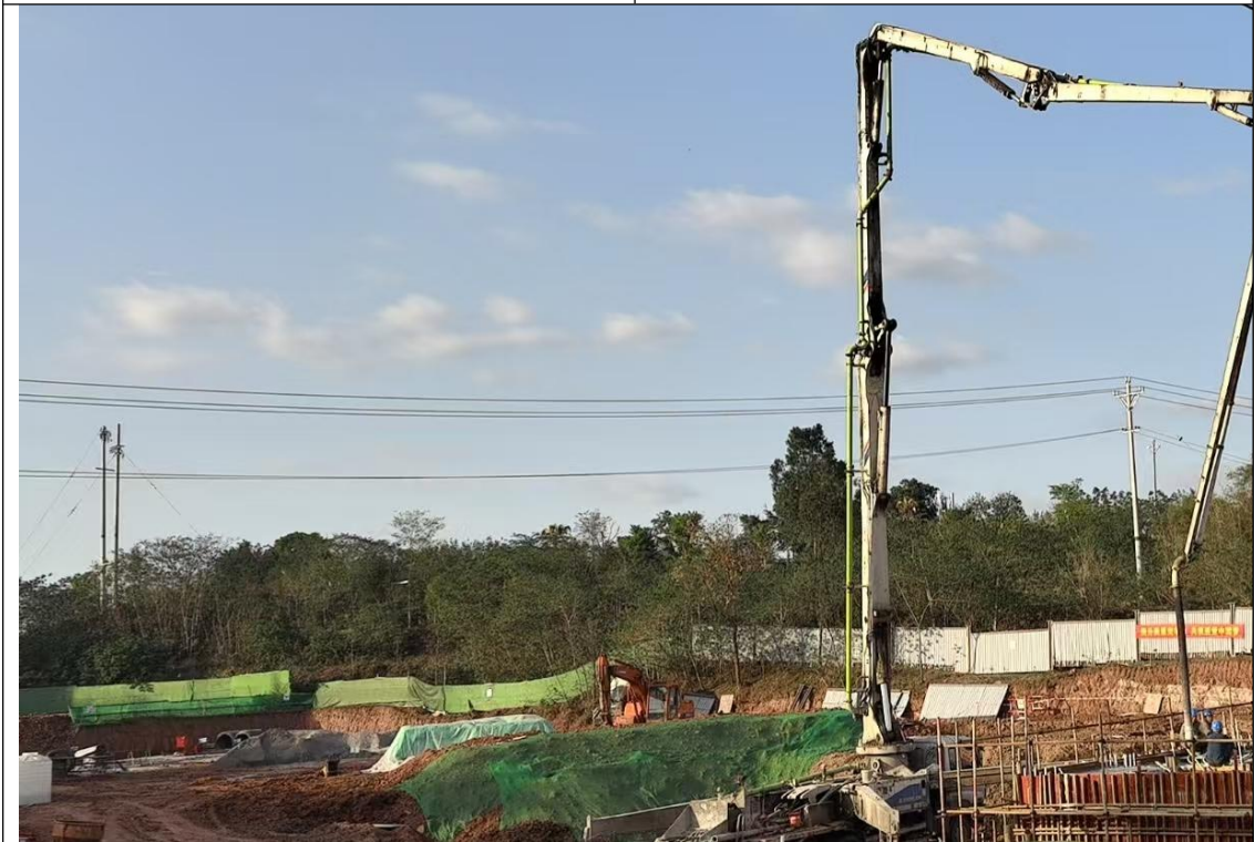
东山变电站施工过程中表土单独堆放、防尘网遮盖、四周硬质围挡
