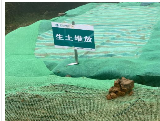
塔基施工过程中分层堆放
