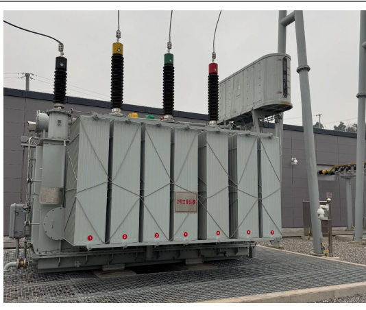
2#主变（集油坑铺设石子）
