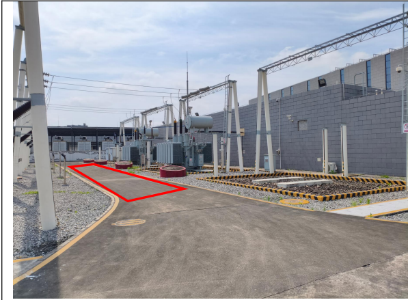
李子坡 110kV 变电站间隔完善工程施工临时材料堆放硬化地面现状
