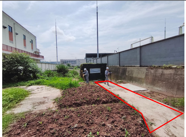
新建电缆线路施工临时材料堆放硬化地面现状
