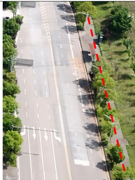
拆除电缆施工临时材料堆放硬化地面现状
